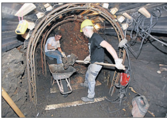
Arbeit unter Tage: Luis del Canto (links) und Dietmar Rebensdorf bauen den Stollen unter der Friedrich-Ebert-Straße.
