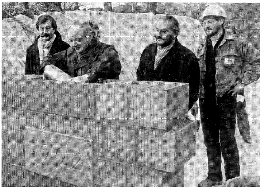
Bei der Grundsteinlegung für die Erweiterung des Hessenkollegs (von links): Schulleiter Martin Witzel, Reinhold Endreß vom Hessischen Kultusministerium und Gerhard Ickler, Leiter des Staatsbauamtes Kassel.
